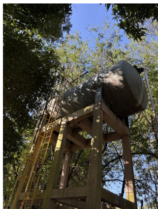
Reservatório elevado da fábrica, a quase 1 km da caldeira, em área de mata.
