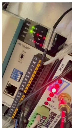
Painel de campo: CLP Haiwell AT12M0P e rádio modem Alfacomp RM-SX900.
