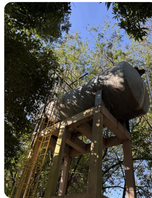
Reservatório a quase 1 km da caldeira
